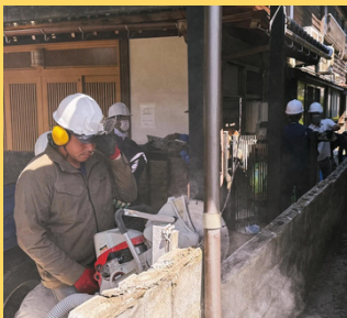
倒壊しそうなブロック塀を撤去の様子
